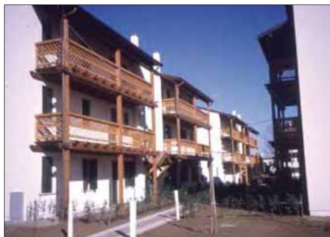
Foto 4 - I 36 alloggi a lavori ultimati
