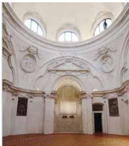
Mantova - Restauro della Sagrestia dell'Archivio di Stato
