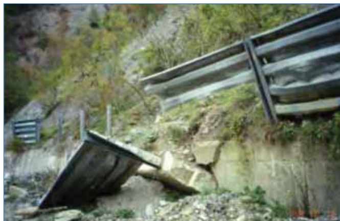
Figura 6 – Barriera paramassi di tipo elastico – Emax ≈ 5.000 kJ
