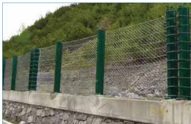
Figura 5 – Barriera paramassi di tipo semi-rigido (travi e funi) – Emax ≈ 20 kJ
