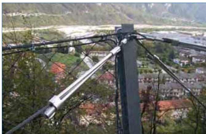
Figura 7 – Particolare sistema frenante a contrasto
