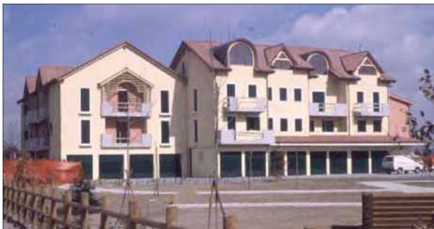
Foto 2 - I 28 alloggi visti dagli orti urbani
