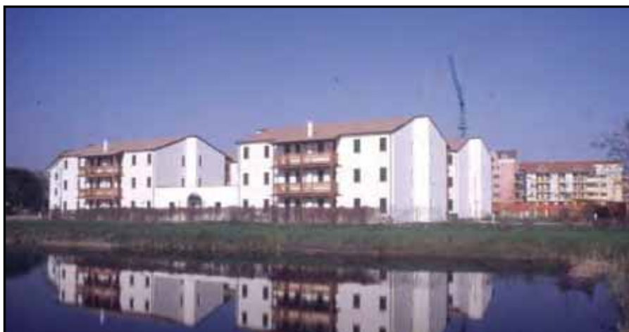
Foto 5 - Immagine di insieme dei 36 alloggi e dei locali accessori
