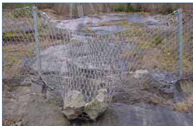
Figura 6 – Barriera paramassi di tipo elastico – Emax ≈ 5.000 kJ
