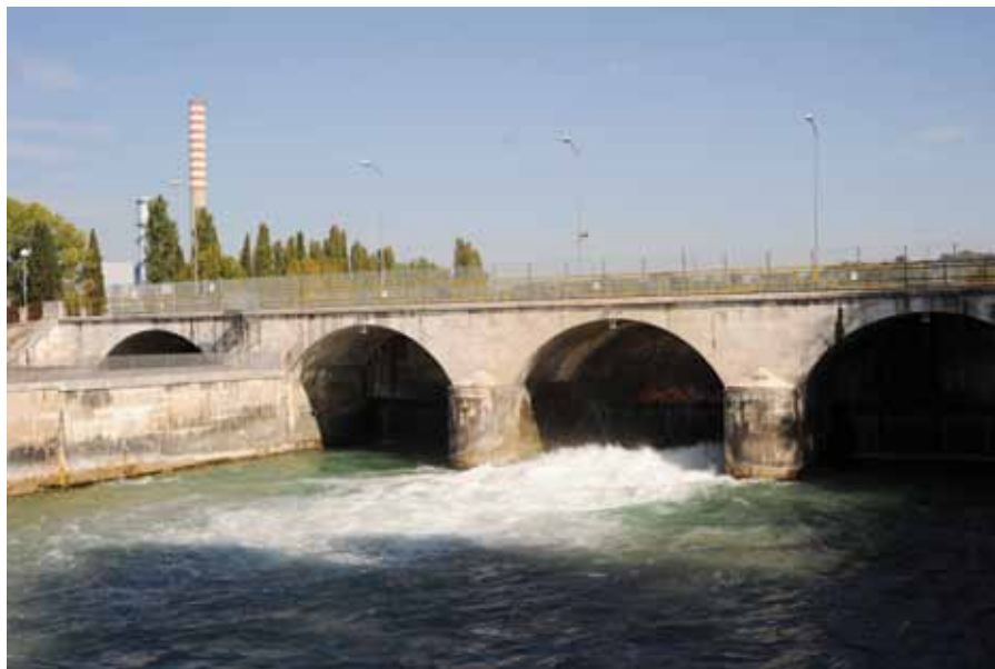
Fig 2 - L'edificio regolatore dei livelli del Lago di Garda a Ponti sul Mincio
