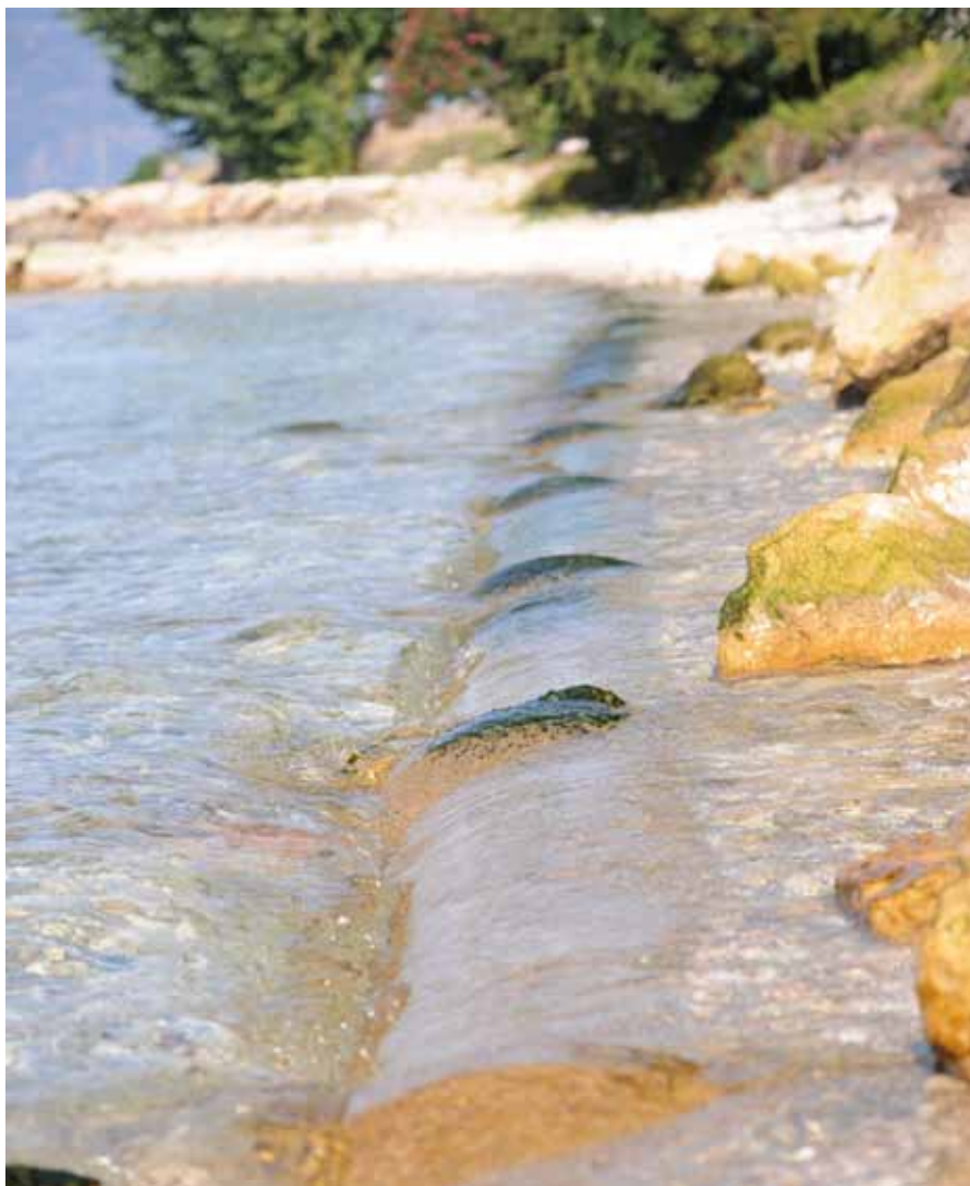
Fig 10 - Porzione del collettore dell'Alto Lago Veronese esistente: la tubazione è disposta sotto il livello del lago
