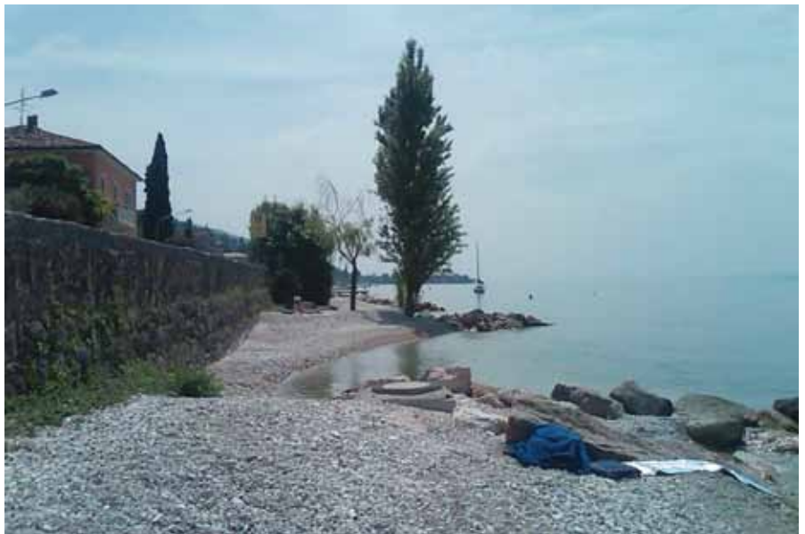
Fig 9 - Pozzetti di ispezione del collettore dell'Alto Lago Veronese esistente: la tubazione è disposta sotto il livello del lago.
