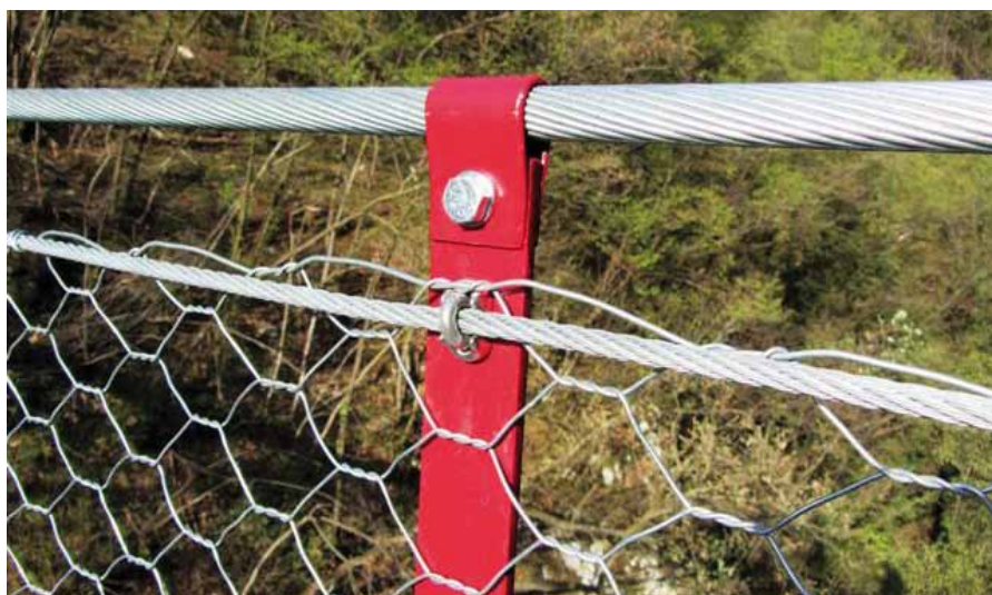
Particolare del parapetto
