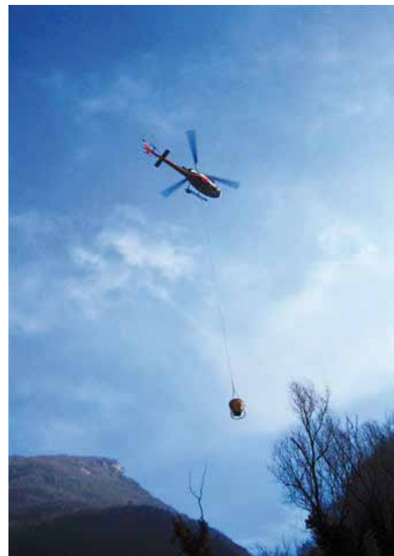
Fig. 5 – Disegno e principali caratteristiche dell'elicottero Eurocopter AS 350 B3 "Ecoureuil". Nella foto il getto del calcestruzzo dei plinti con l'elicottero.
