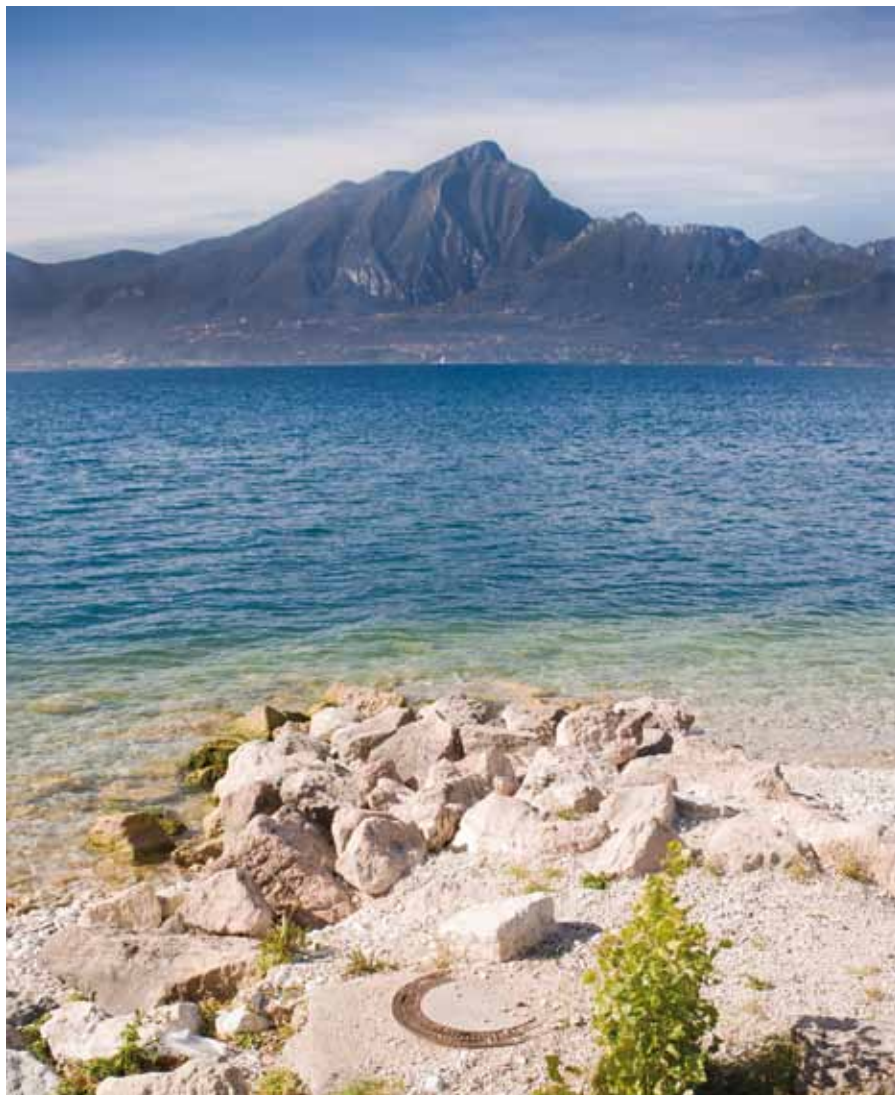
Fig 3 - Pozzetto di ispezione lungo il collettore esistente, in fregio al lago di Garda
