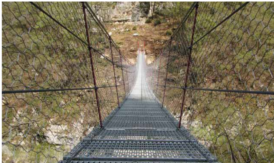
Il piano calpestabile del ponte
