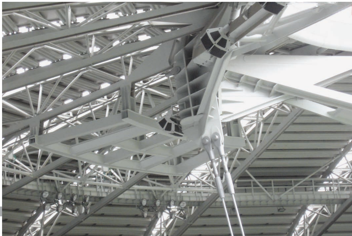
Fig. 6 - I maestosi nodi posti all'incontro delle travi reticolari principali
