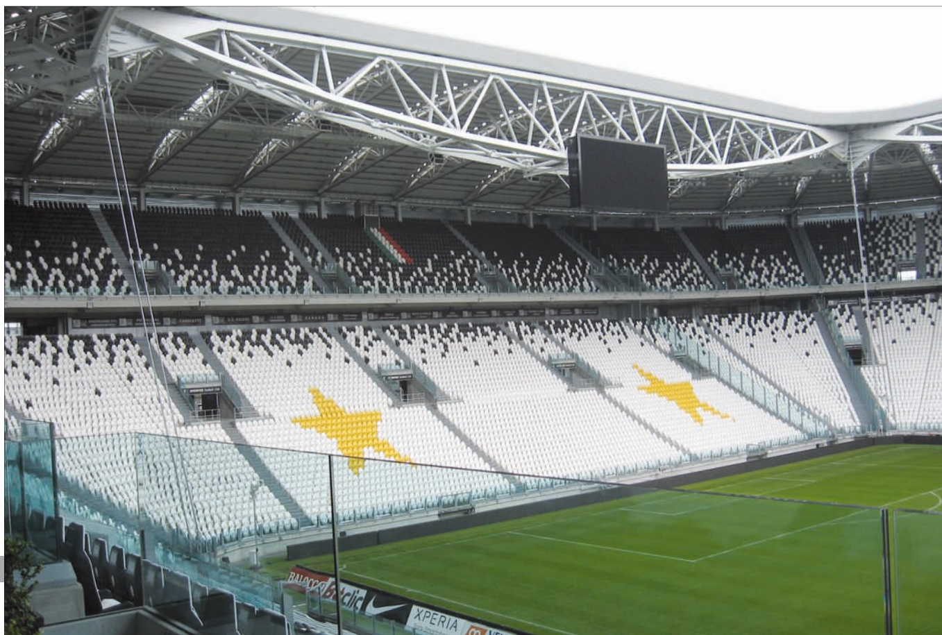
Fig. 5 - La struttura in acciaio dello stadio e il campo da calcio.
