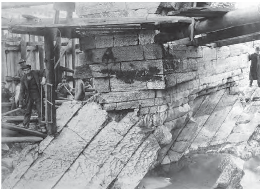
• Rimozione del masso vicino alla pila (in alto) e sostituzione della pietra di fondazione danneggiata dalla corrente (in basso), 1894 [BCVr].
