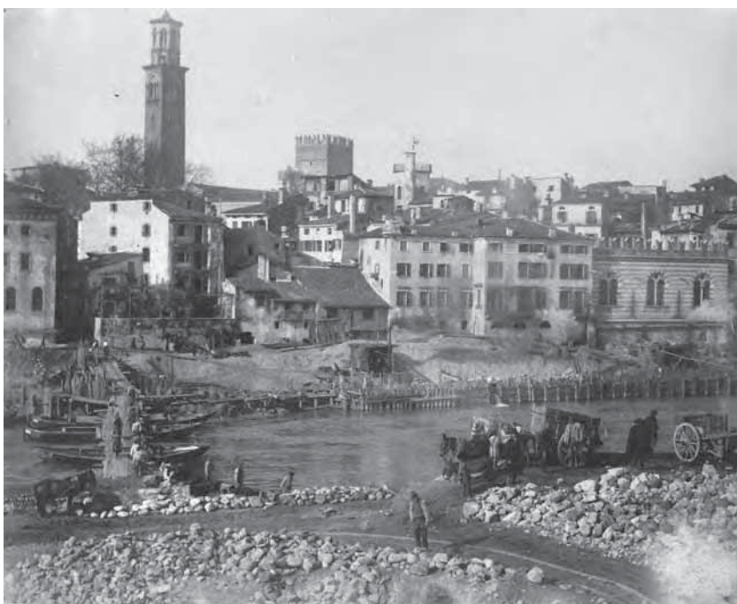
• Lavori all'Isolo, veduta di via Sanmicheli durante i lavori di demolizione dell'isolato davanti alla chiesa di S. Tomaso (in alto) e veduta dei casseri al Vo del Cristo (in basso), 1891 [BCVr].
