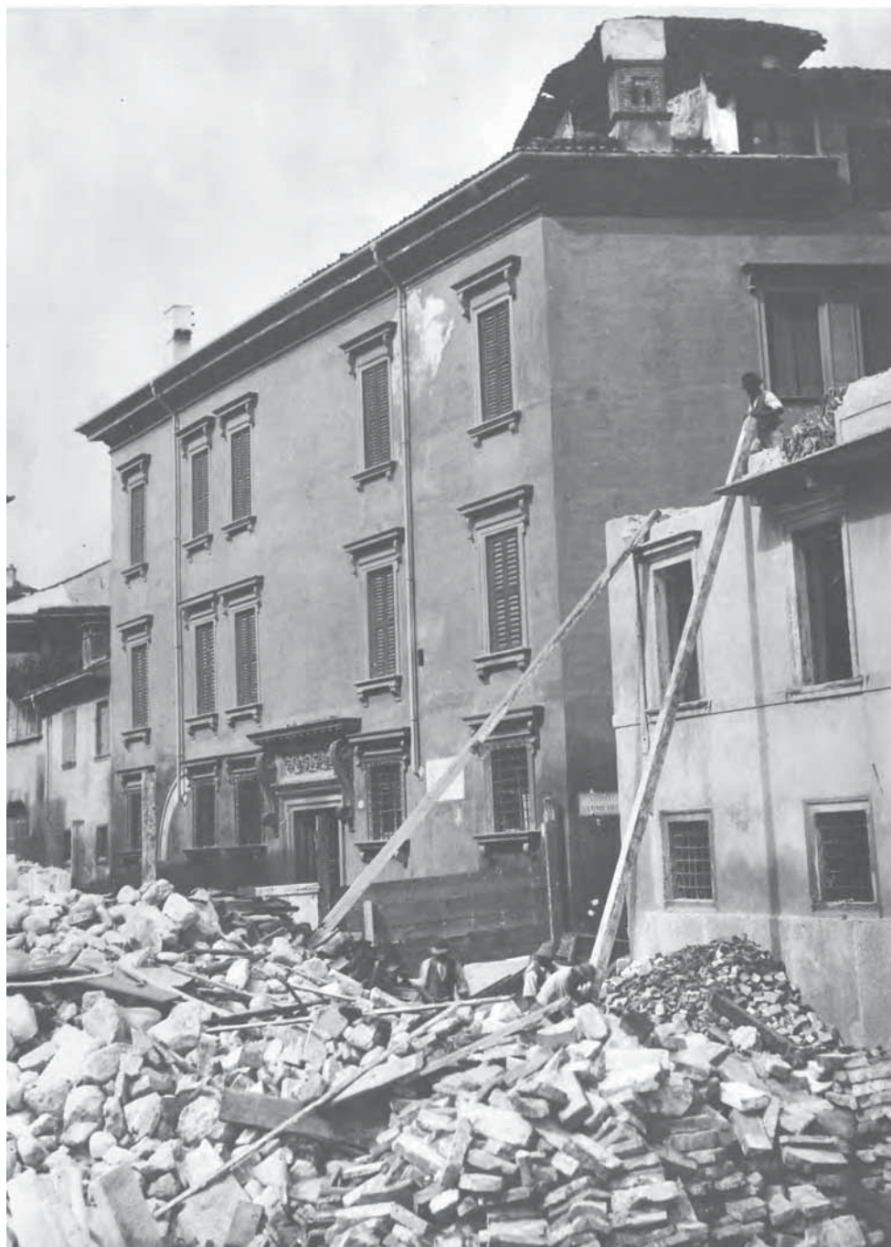
• Vista della casa di Michele Sanmicheli durante la demolizione dell'isolato a S. Tomaso, 1894, [BCVr].
