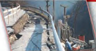
Operativi con tutte le varianti riguardanti i tipi di micropalo, con diametri da mm 127 a 400, con portata di esercizio fino ad oltre 100 ton.
