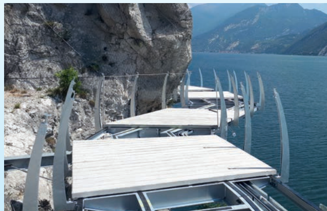
CICLOPISTA DEL GARDA . Pannelli in c.a. per pista montati da elicottero
