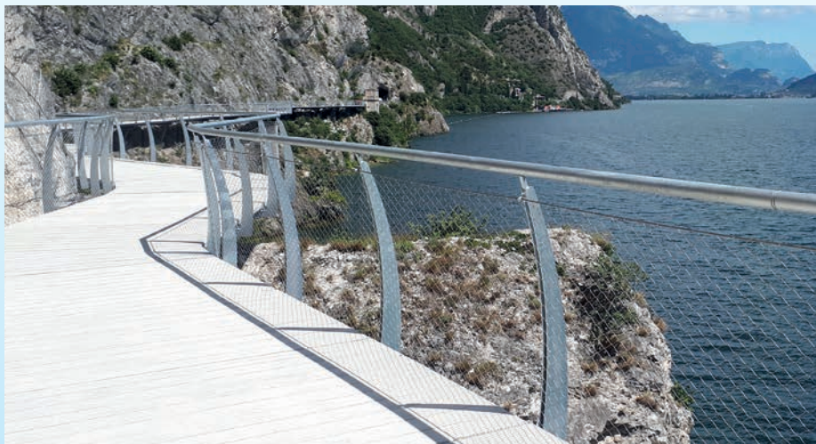
CICLOPISTA DEL GARDA . Pannelli in c.a. per pista montati da elicottero
