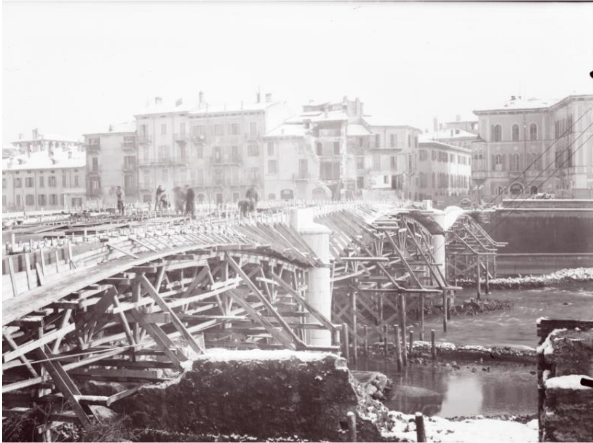
Foto del cantiere di ponte Garibaldi, 1934 (BCVr)
