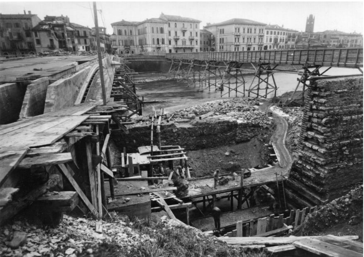
Foto del cantiere di ponte Garibaldi, 1933 (Archivio del Genio Civile, ASVr)
