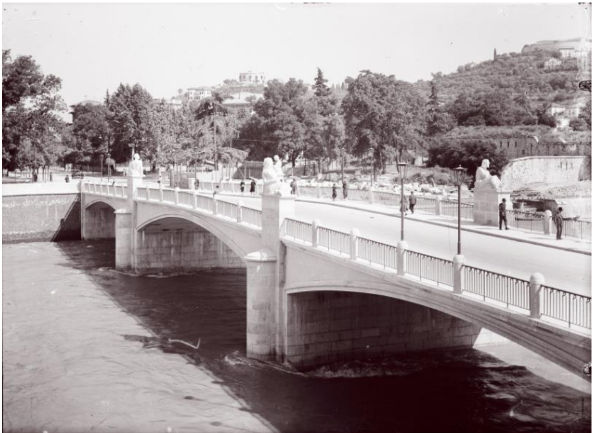
Ponte Garibaldi, 1935 (BCVr)
