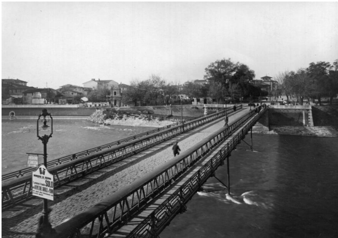
Ponte Garibaldi, 1930 (Archivio del Genio Civile, ASVr)
