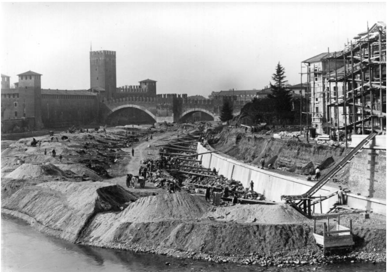
Il cantiere alla Campagnola, 1931 (Archivio del Genio Civile, ASVr)
