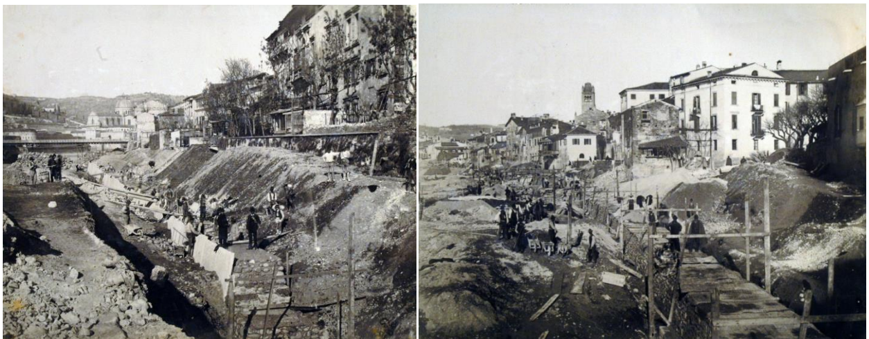
Lavori presso la riva di san Lorenzo e a Castelvecchio, 1889 (BCVr)
