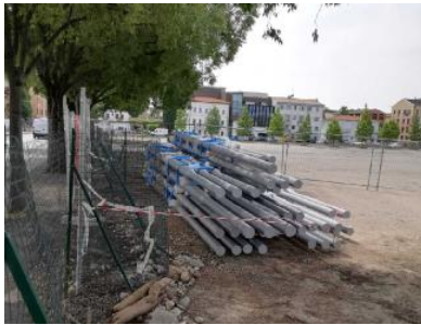
I pali di sostegno dei fili elettrici pronti per essere montati
