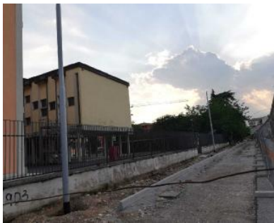
Pali già installati in una delle strade sul percorso del filobus
