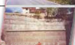
Questa tecnica può sostituire, in alcuni casi, le tradizionali berlinesi, o può mantenere stabile un versante con un paramento esterno a verde. Primo cantiere Soil-Nailing realizzato nel 1989.
