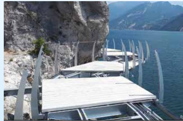
CICLOPISTA DEL GARDA . Pannelli in c.a. per pista montati da elicottero
