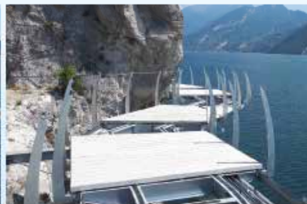
CICLOPISTA DEL GARDA. Pannelli in c.a. per pista mortati da elicottero
