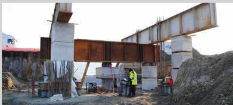
Autovie Venete – Collaudo sottopassaggi su terza corsia Autostrada A4
