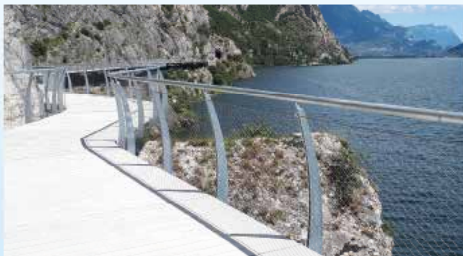
CICLOPISTA DEL GARDA. Pannelli in c.a. per pista mortati da elicottero
