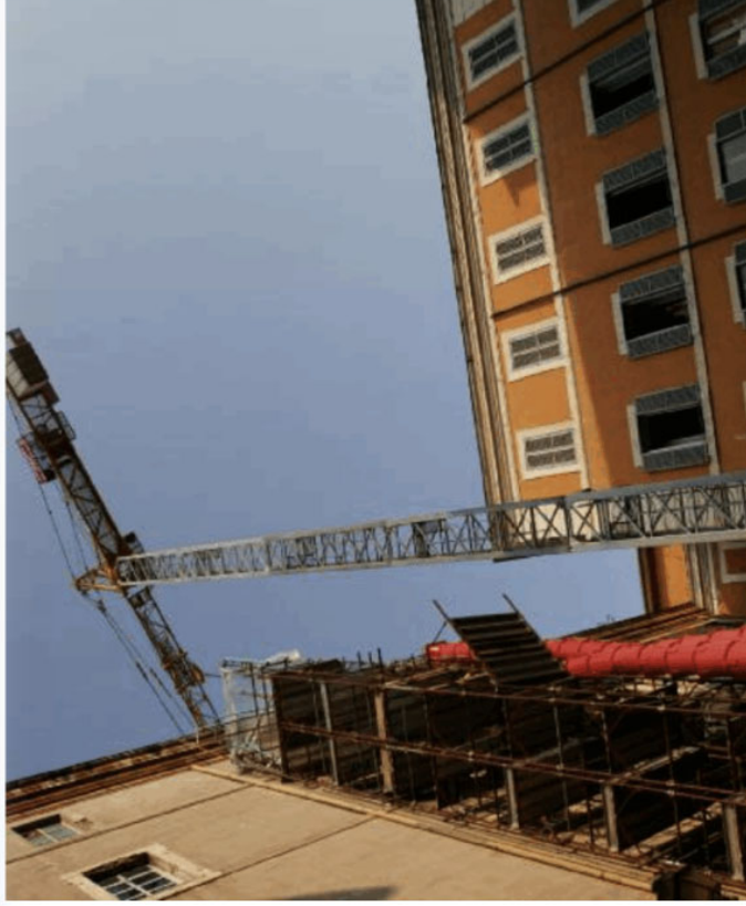
Cantieri Il 75% delle abitazioni presenti in provincia necessiterebbero di riqualificazioni
