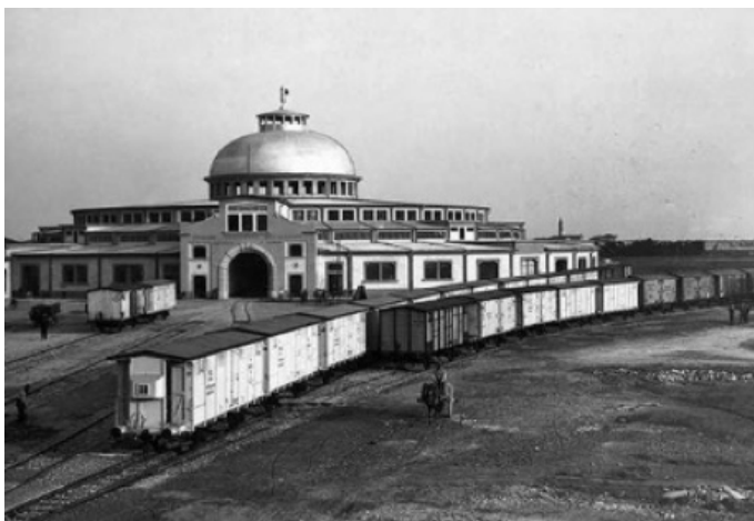
Centrale Frigorifera Specializzata
