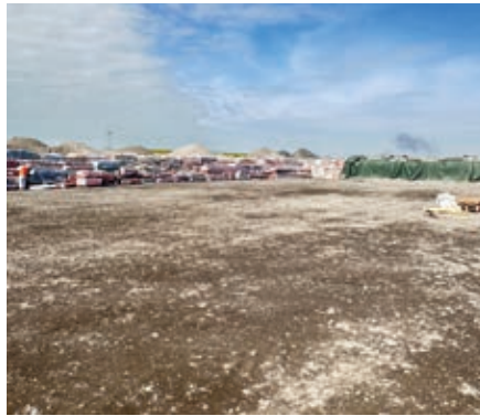
Vista del fronte di scarico durante le attività operative
