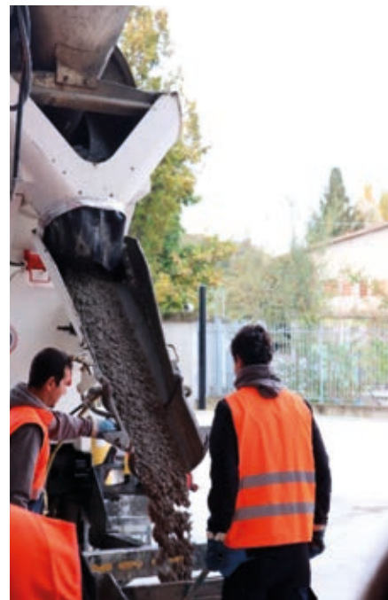
Nelle foto (da sinistra a destra): zona prove sul calcestruzzo, targa del centenario dell'ordine, alcuni dei mezzi Betonrossi e il momento dello scarico del calcestruzzo per le prove sul materiale fresco.
