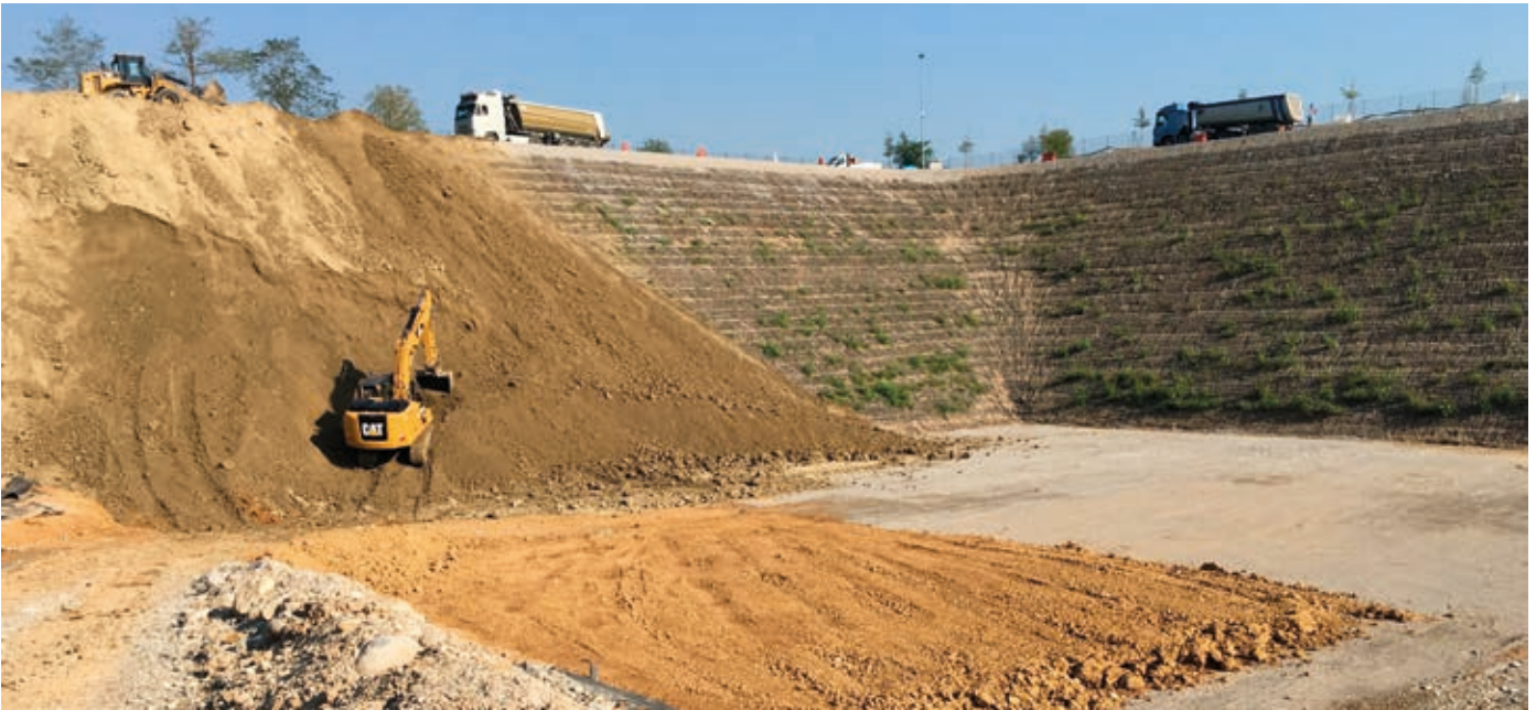
Costruzione lotto di discarica. Terre armate (a destra) e posa argilla in parete (a sinistra)
