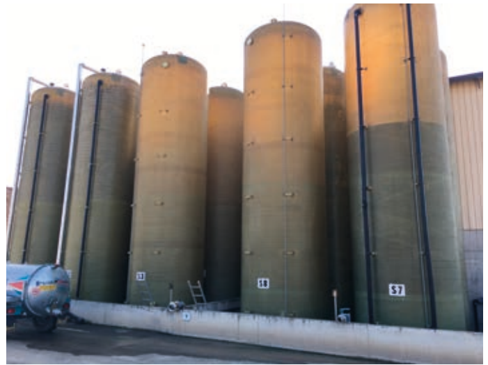
Prelievo del percolato da fondo vasca con pompe sommerse (a sinistra) e stoccaggio in serbatoi dedicati (a destra)
