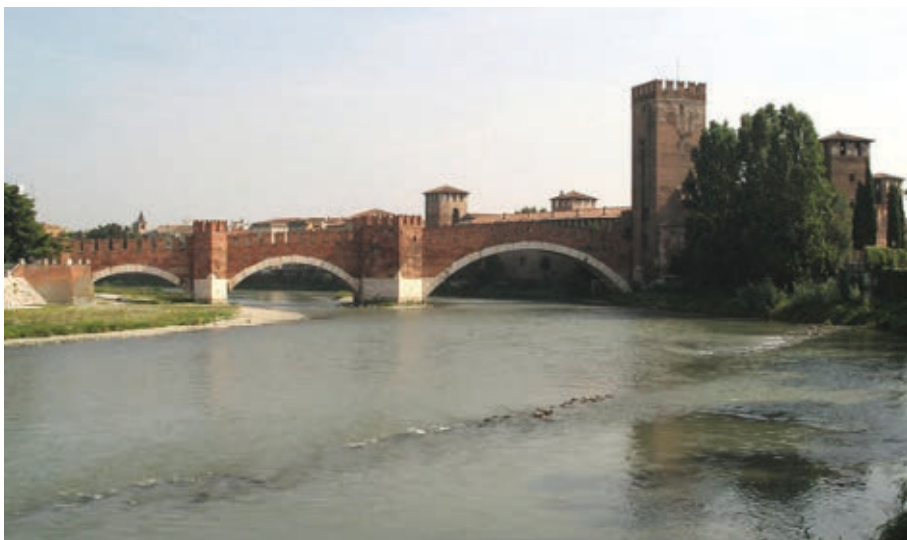
Foto 1: Ponte Castelvecchio di Verona. Fonte dal web
