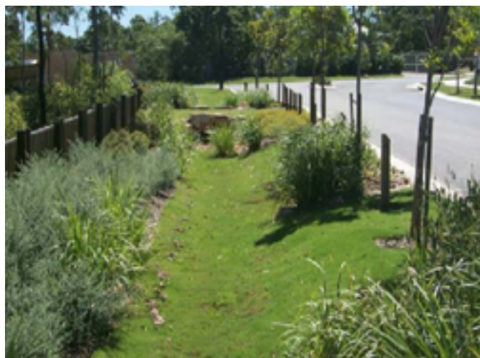
Fig. 5 - schema di depressione erbosa (Los Angeles stormwater manual - EPA)
