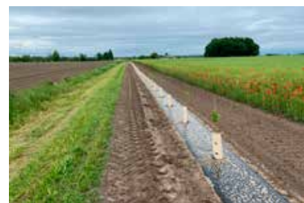
Realizzazione di fascia tampone con telo pacciamante e fascia di rispetto contigua al corso d'acqua
