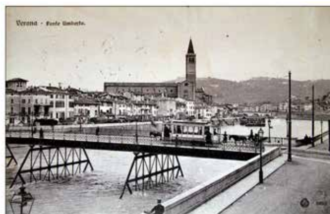
Ponte Nuovo - Umberto I° - 1910 c.a.
