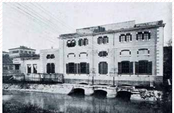
Officina idroelettrica - Prospetto del fabbricato a levante
