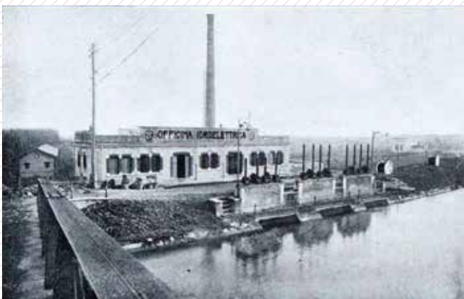
Officina idroelettrica - Prospetto del fabbricato a ponente
